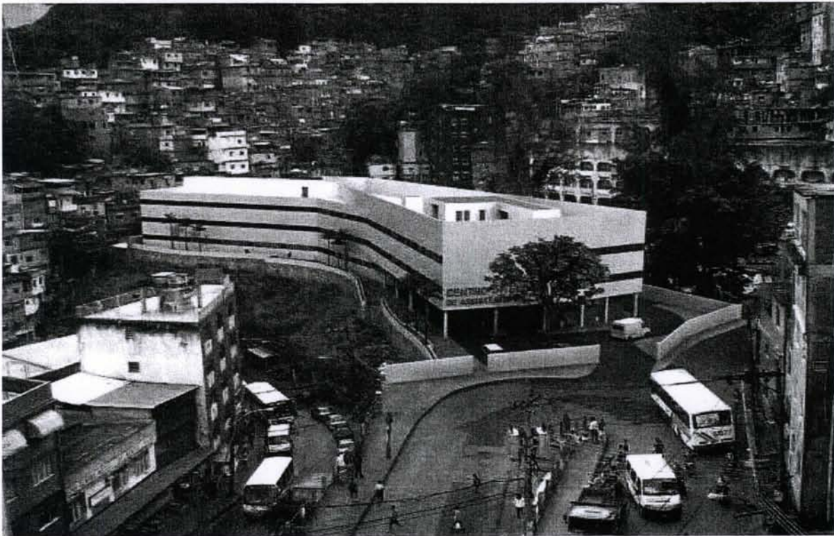
La construction future de l'hôpital fait partie du vaste chantier (Projet pour l'accélération de la croissance PAC) lancé par le président Lula en 2007 dans 3 favelas brésiliennes. Source: journal brésilien Globo.com (août 2009).
